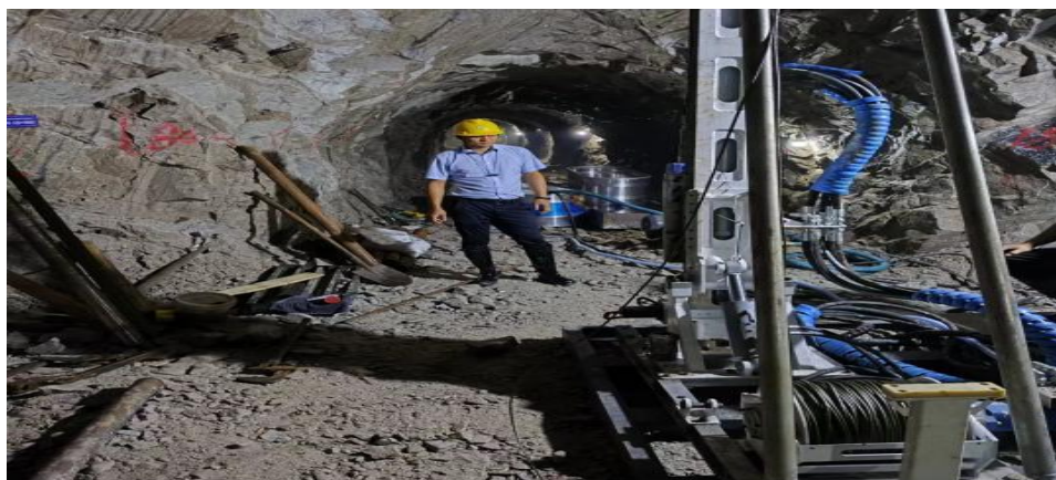
图 3-8 深长隧道作业测试
