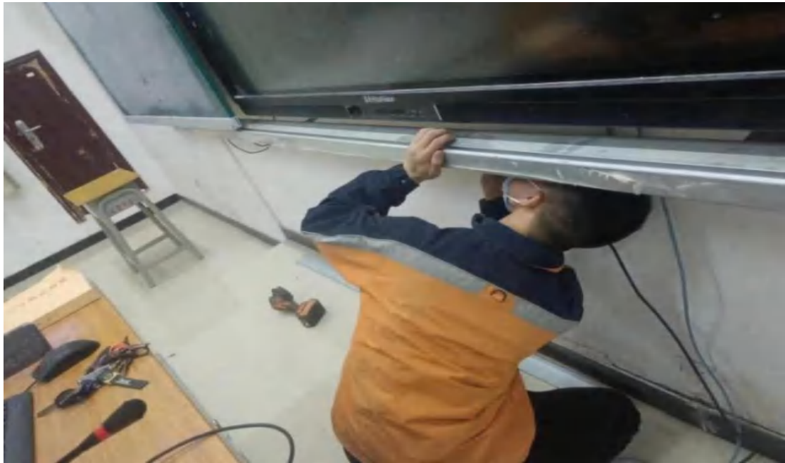
图 3-18 机电工程系学生郑红新在学校各个角落进行维修
