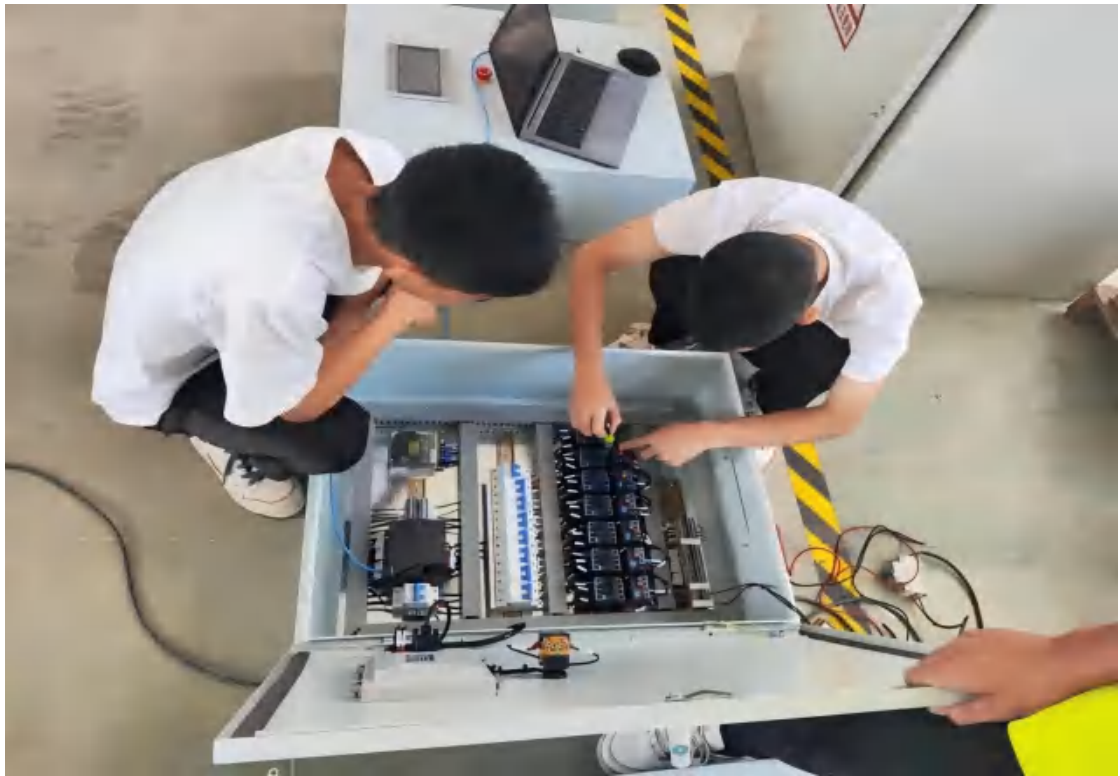
图 2-2 零陵机场油榨头村污水处理控制柜
